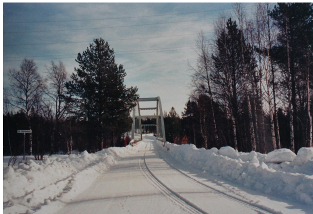
Bron över Ängesån i Tväredet
